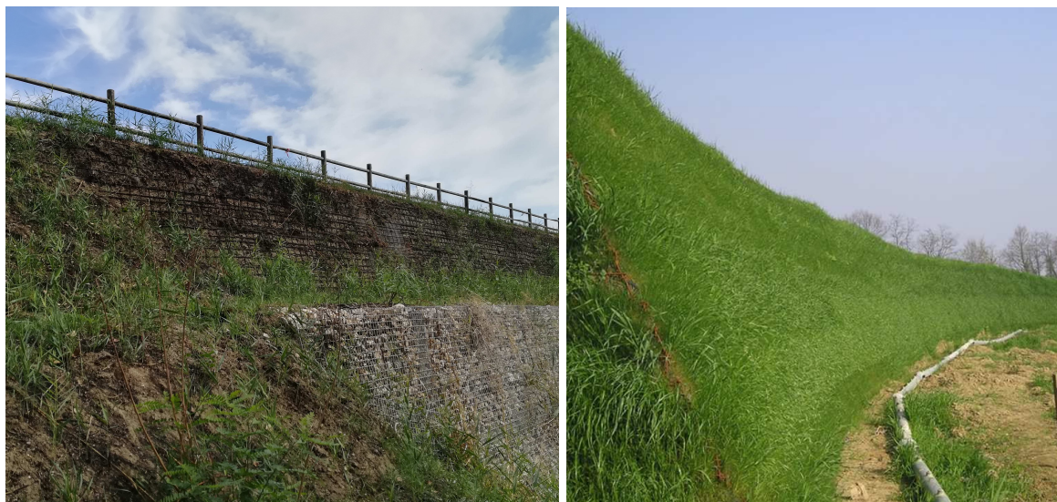
Terra armata bruciata a Polesella (sx) – Terra armata tipo rinverdità dopo idrosemina (dx)
